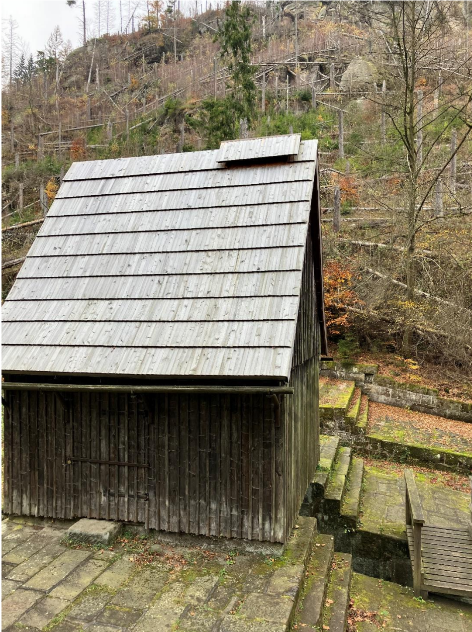
Bild 3: Niedere Schleuse an der Kirnitzsch.
