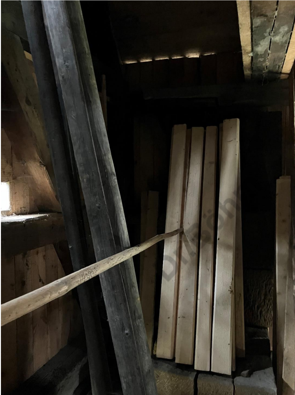
Bild 4: Niedere Schleuse mit Stauhölzern beziehungsweise Staustufen.
