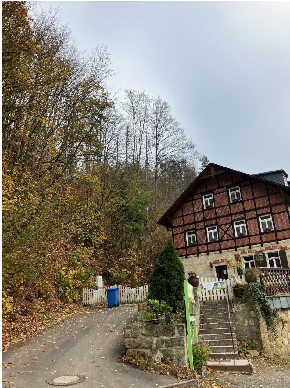
Bild 7: Hotel und Restaurant Forsthaus (Kirnitzschtalstraße 5, Große Kreisstadt Sebnitz).
